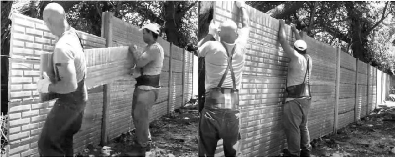
El siguiente paso será encastrar el poste (que habíamos dejado suelto en el pozo) con la hilada de placas. Siempre corroborar que quede a nivel y plomo. Fijar con escombros, pisón y hormigón mencionados anteriormente.
