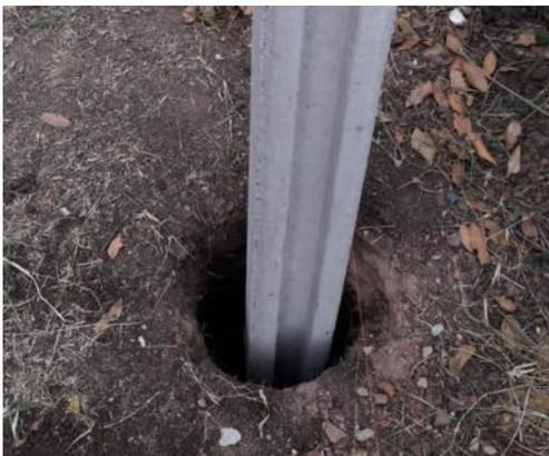
Si usted cuenta con nuestro molde poste U, podrá comenzar colocando esta pieza en el piso (va suelta, el mismo peso de las placas la fija y define su posición). Si no cuenta con poste U, solo arranque con la primer placa al piso insertando la misma a la ranura del poste.
